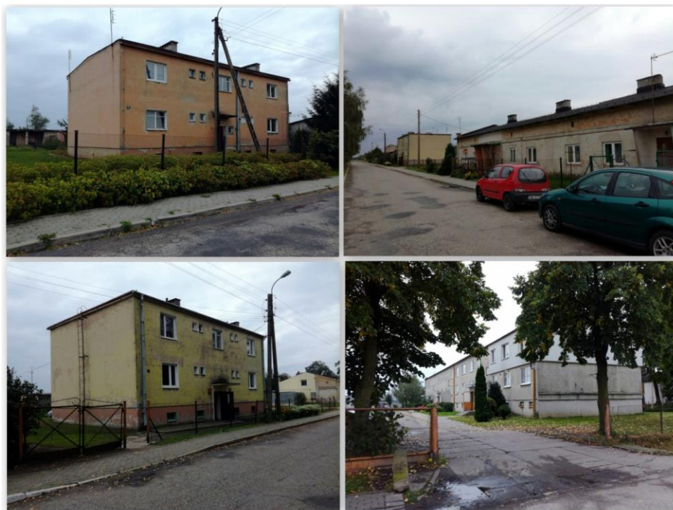
Rysunek 9. Stan techniczny budynków mieszkalnych w Jarantowicach
