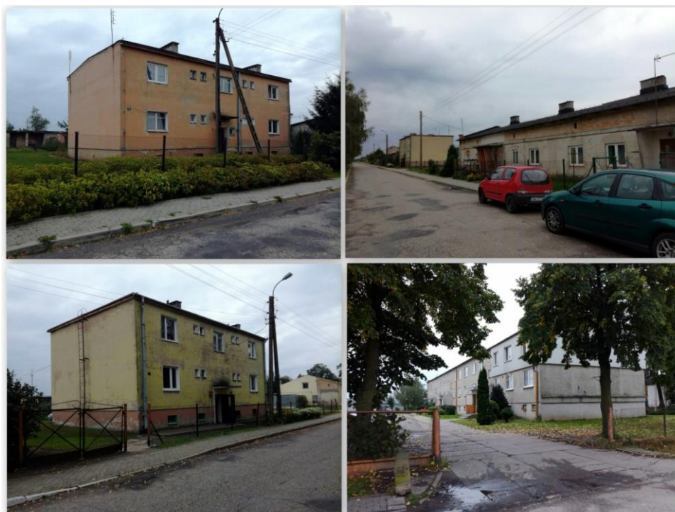
Rysunek 9. Stan techniczny budynków mieszkalnych w Jarantowicach
