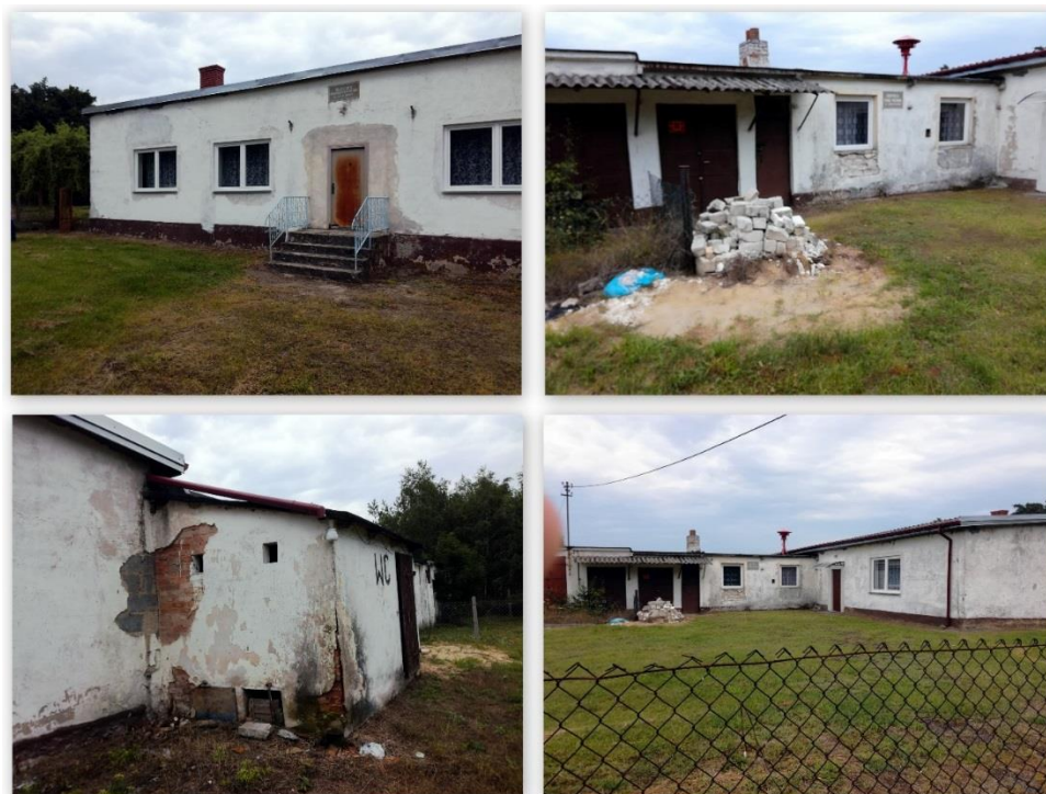
Rysunek 11. Świetlica wiejska w Szczutkowie
