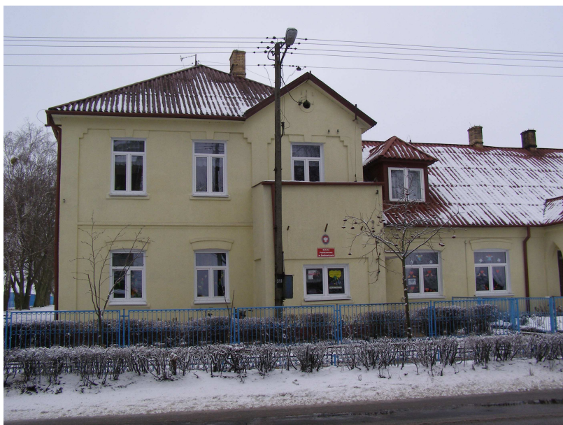
Budynek Szkoły Podstawowej w Śmiłowicach
